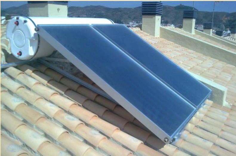
Estos sistemas absorben los rayos del Sol que pasan al agua y hacen que se mantenga caliente en un tanque de almacenamiento, aun durante la noche y en días nublados. Por la insolación que tenemos en México, un metro cuadrado de celdas solares puede recibir diariamente la energía equivalente a un metro cúbico de gas natural o 1.3 litros de gas licuado de petróleo.
